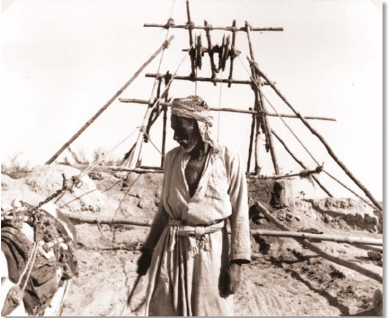
آبار مياه حفرت خصيصاً لسد احتياجات شركة نفط الكويت من الماء في حقل المناقيش
